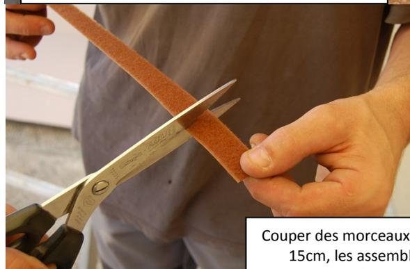
Couper des morceaux de ruban agrippant de 15cm, les assembler sur 5cm puis les attacher sur les chevrons.
