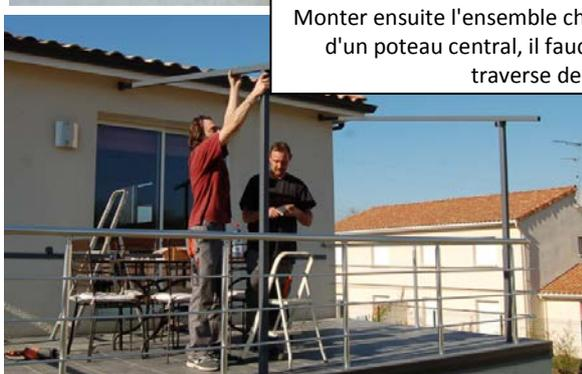
Monter ensuite l'ensemble chevron/poteau suivant, s'il s'agit d'un poteau central, il faudra boulonner un support de traverse de chaque côté.
