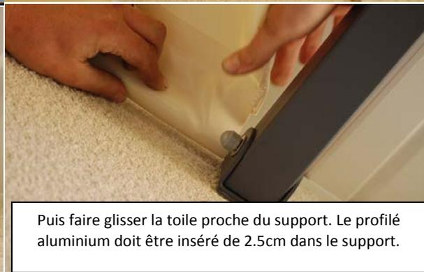
Puis faire glisser la toile proche du support. Le profilé aluminium doit être inséré de 2.5cm dans le support.
