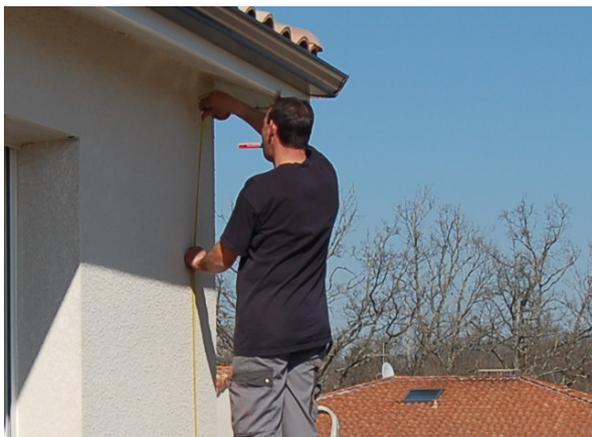
Marquer le premier perçage en suivant les côtes du schéma d'implantation.
