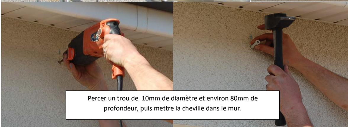
Perçer un trou de 10mm de diamètre et environ 80mm de profondeur, puis mettre la cheville dans le mur.
