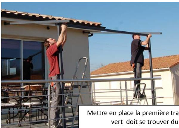
Mettre en place la première traverse et la boulonner. Le repère vert doit se trouver du côté du poteau central.
