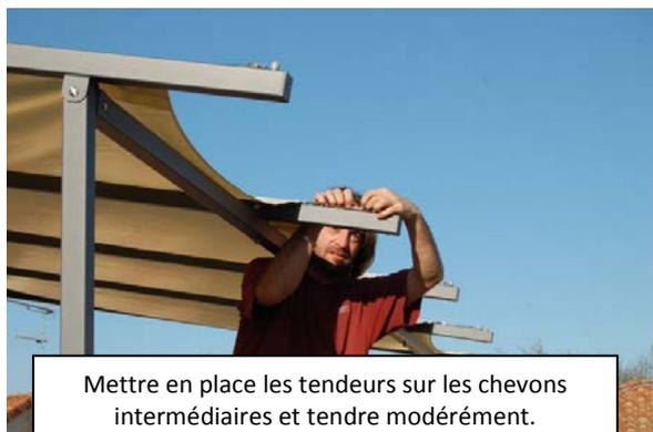
Mettre en place les tendeurs sur les chevrons intermédiaires et tendre modérément.
