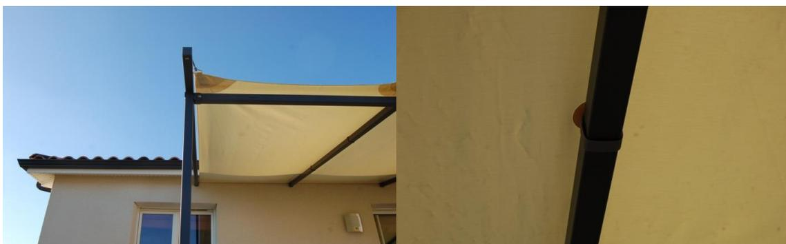
La fixation au mur de l'armature est réalisée au droit de chaque chevron, la visserie livrée est uniquement adaptée à des matériaux maçonnés pleins (il conviendra de se procurer d'autres chevilles pour tout autre type de support).
