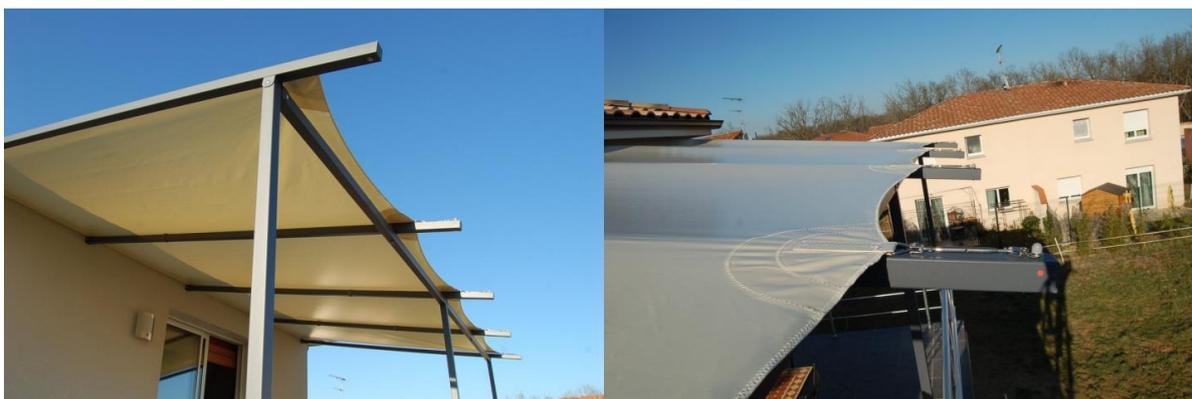
Sa structure est composée de profilés aluminium carrés de section 50\*50mm et de pièces de jonction en acier, l'ensemble est thermo laqué époxy de couleur gris anthracite (RAL 7015) mat avec un aspect grainé.
