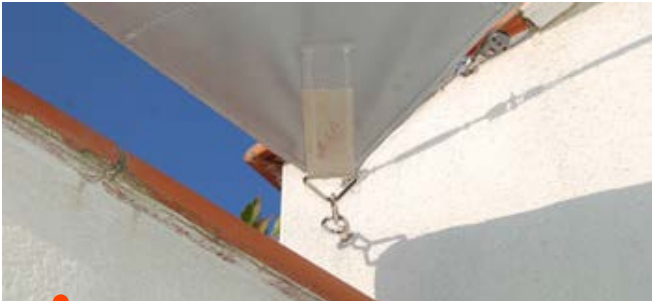
Point d'ancrage fixe (démontable par mousqueton)
